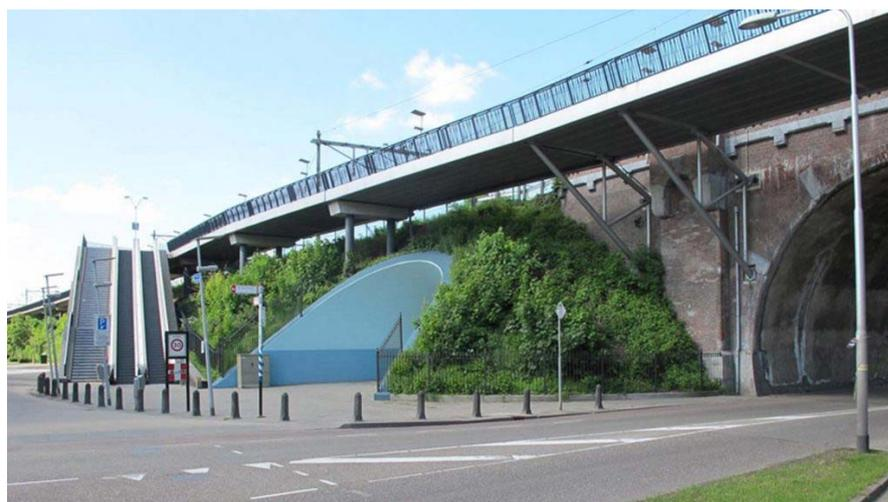
Рисунок 3.3.3.1.4 – Крепление велопешеходной части к железнодорожному мосту в Неймегене, Нидерланды (источник: Bicycle Dutch)
